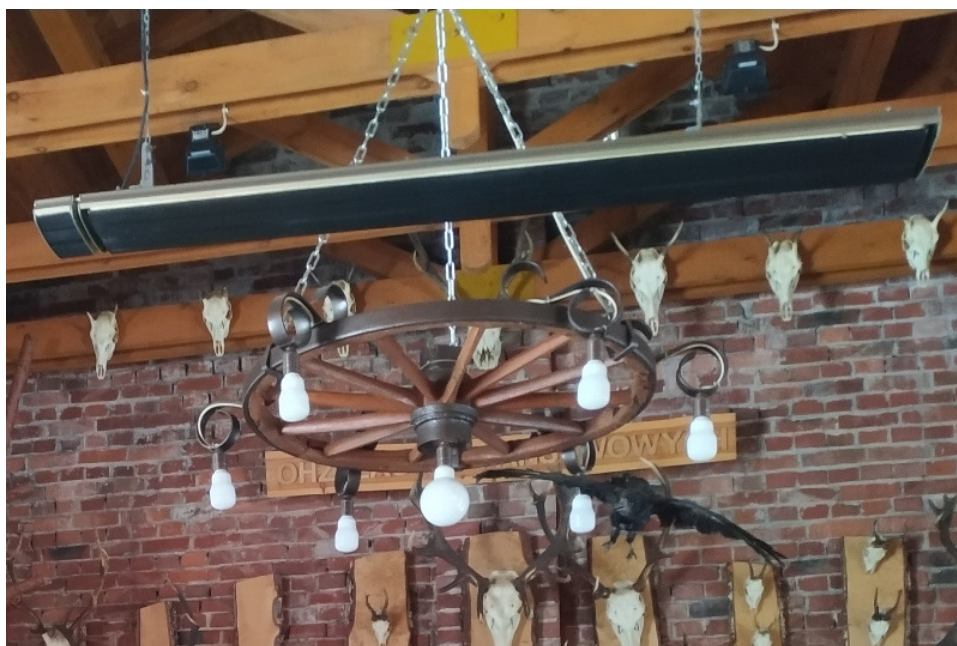
Rys. 6. Elektryczny promiennik podczerwieni o mocy 1000 W
